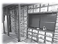
断熱入りの壁に浸水したら、「断熱材が水を含み時間経過すると異臭が発生」処置は取り除くほかにありません。
