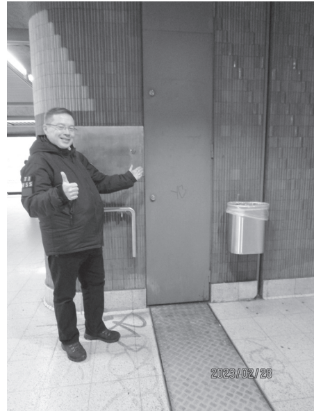
写真4 c 気密扉（出入口側）
